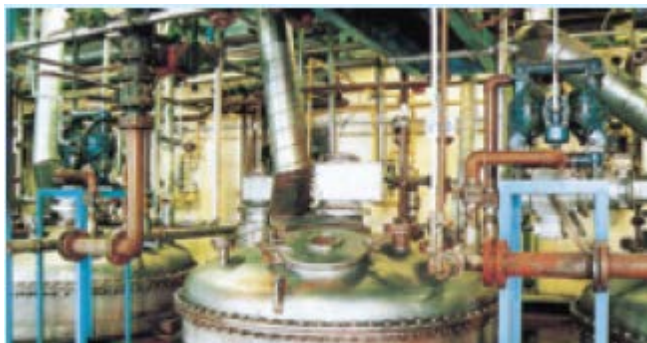
Насосы Vlagdon 50 заполняют кольцевой магистральный трубопровод для проведения окончательного смешивания в установке по выпуску покрытий.
