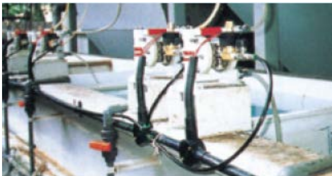
Литые пластиковые насосы Vlagdon 06 используются сингапурской фирмой Duraco Industries для впрыска химикатов на предприятии по очистке сточных вод.
